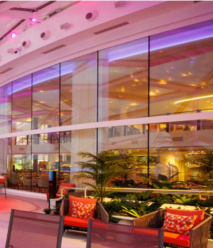
El sistema se sometió a pruebas para garantizar que cumpliera las normas de seguridad contra incendios requeridas en sector marítimo. Las pruebas se llevaron a cabo en Francia, en el laboratorio de ensayo acreditado Efectis. Para cumplir los requisitos de la clase A60, el sistema debe resistir las llamas durante 60 minutos sin que se encienda la cara no expuesta. El sistema superó las pruebas, alcanzando la clase A60 para paredes rectas y la clase A30 para paredes facetadas.
