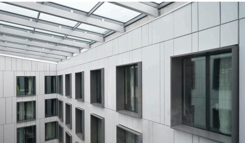
Installé dans un cadre en aluminium, le verre Pyroguard Protect EI60 a été spécifié pour 98 fenêtres de chambre.
