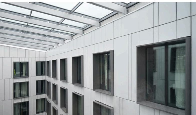
Instalado dentro de un marco de aluminio, Pyroguard Protect EI60 se especificó en 98 ventanas repartidas por las habitaciones del hotel.
