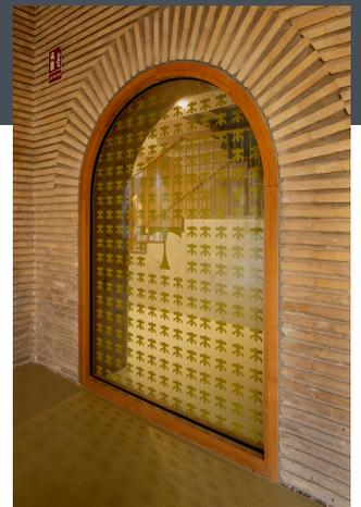
Il telaio AFVidrio, con la collaborazione con Pyroguard, è quindi stato sottoposto a un test EI120 per la resistenza al fuoco. Questo test rappresentava una fase critica del progetto per garantire le prestazioni dell'intero sistema vetrato. Le competenze e le conoscenze tecniche di Pyroguard sono state fondamentali per contribuire alla progettazione e al superamento del test EI120, che prevedeva l'uso del vetro resistente al fuoco Pyroguard Protect.
