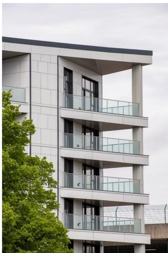
Pyroguard Balustrade. Il sistema, totalmente supportato da calcoli strutturali specifici per il sito, è conforme a tutti i più recenti requisiti previsti dal Regolamento edilizio per la realizzazione di edifici residenziali di altezza superiore ai 18 metri (11 metri in Scozia).
