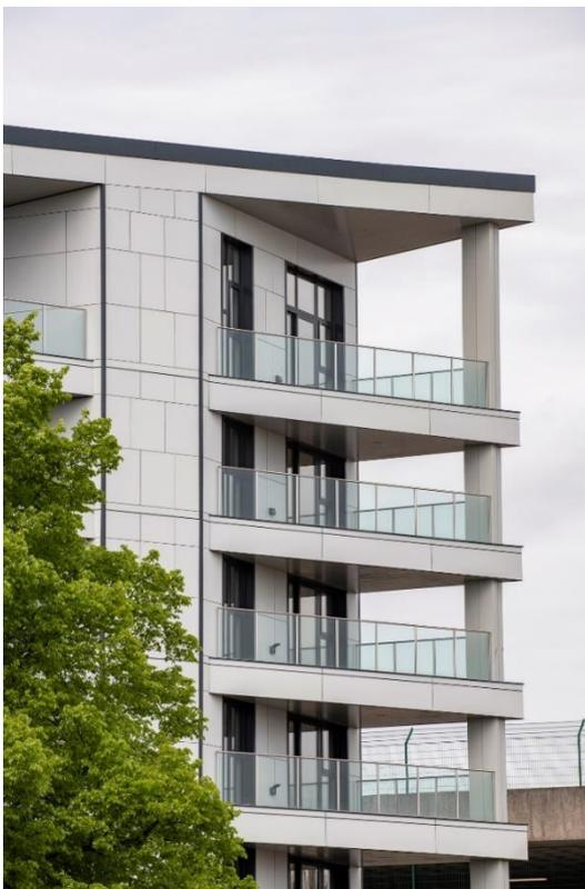
incendie Balustrade de Pyroguard. Le système, entièrement étayé par des calculs structurels spécifiques au site, est conforme à toutes les dernières réglementations en vigueur pour les bâtiments résidentiels de plus de 18 mètres (11 mètres en Écosse) de haut.
