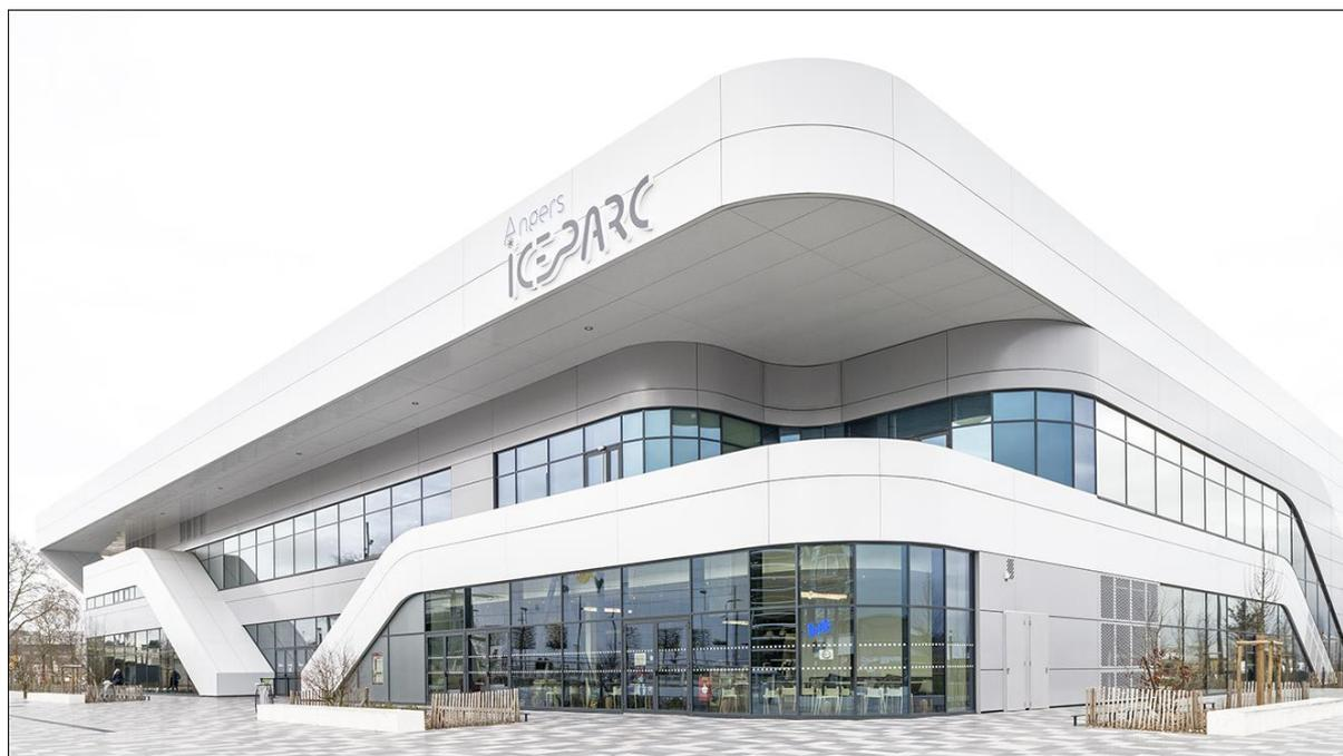
**Prodotto secondo una specifica su misura, la gamma di vetri temprati Pyroguard Protect è stata recentemente installata all'interno del nuovo Angers ICEPARC ad Angers, in Francia. Per l'ambizioso progetto architettonico, in cui sicurezza e design erano fondamentali, Pyroguard T-EI60/25-3 ha fornito 60 minuti di integrità e isolamento termico, oltre alla classificazione all'impatto 1B1, stabilità ai raggi UV e alte prestazioni acustiche per la parete divisoria interna in vetro curvo.**
