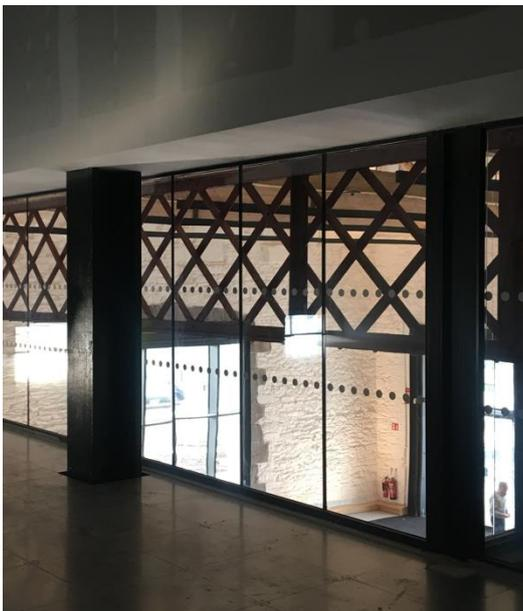
Pyroguard Infinity es una gama de vidrio resistente al fuego certificada para aplicaciones a testa. Al no requerir perfiles perimetrales, es la solución ideal para proporcionar particiones vidriadas visualmente atractivas. Fabricado según la clasificación EI, Pyroguard Infinity proporciona el más alto nivel de integridad y aislamiento térmico, protegiendo contra las llamas, el humo y el calor.
