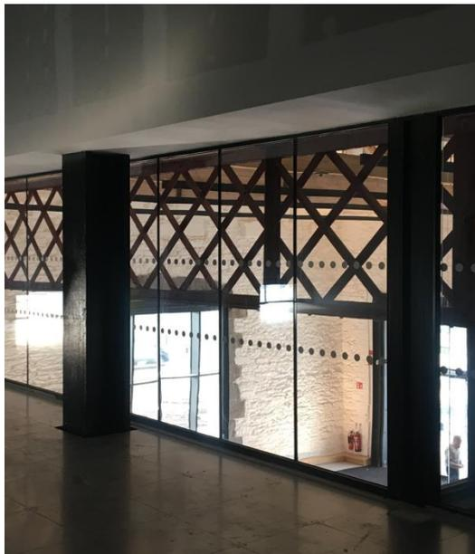
Um sicherzustellen, dass die gewünschte Ästhetik erreicht wird und gleichzeitig die Sicherheitsvorschriften eingehalten werden, entschied sich die KCC Group für das Brandschutzglas Pyroguard Infinity T-EI30/24-2 SWS, das in die verglaste Trennwand in einem Jansen-Stahlprofilssystem eingebaut wurde.
