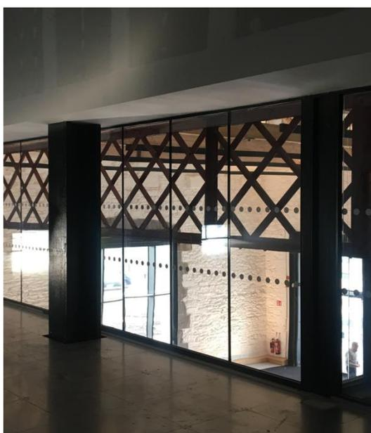
Pour garantir l'esthétique souhaitée, tout en respectant les réglementations en matière de sécurité des bâtiments, le verre de sécurité incendie Pyroguard Infinity T-EI30/24-2 SWS a été choisi par KCC Group et installé dans la cloison vitrée, dans un système de profilés en acier Jansen.
